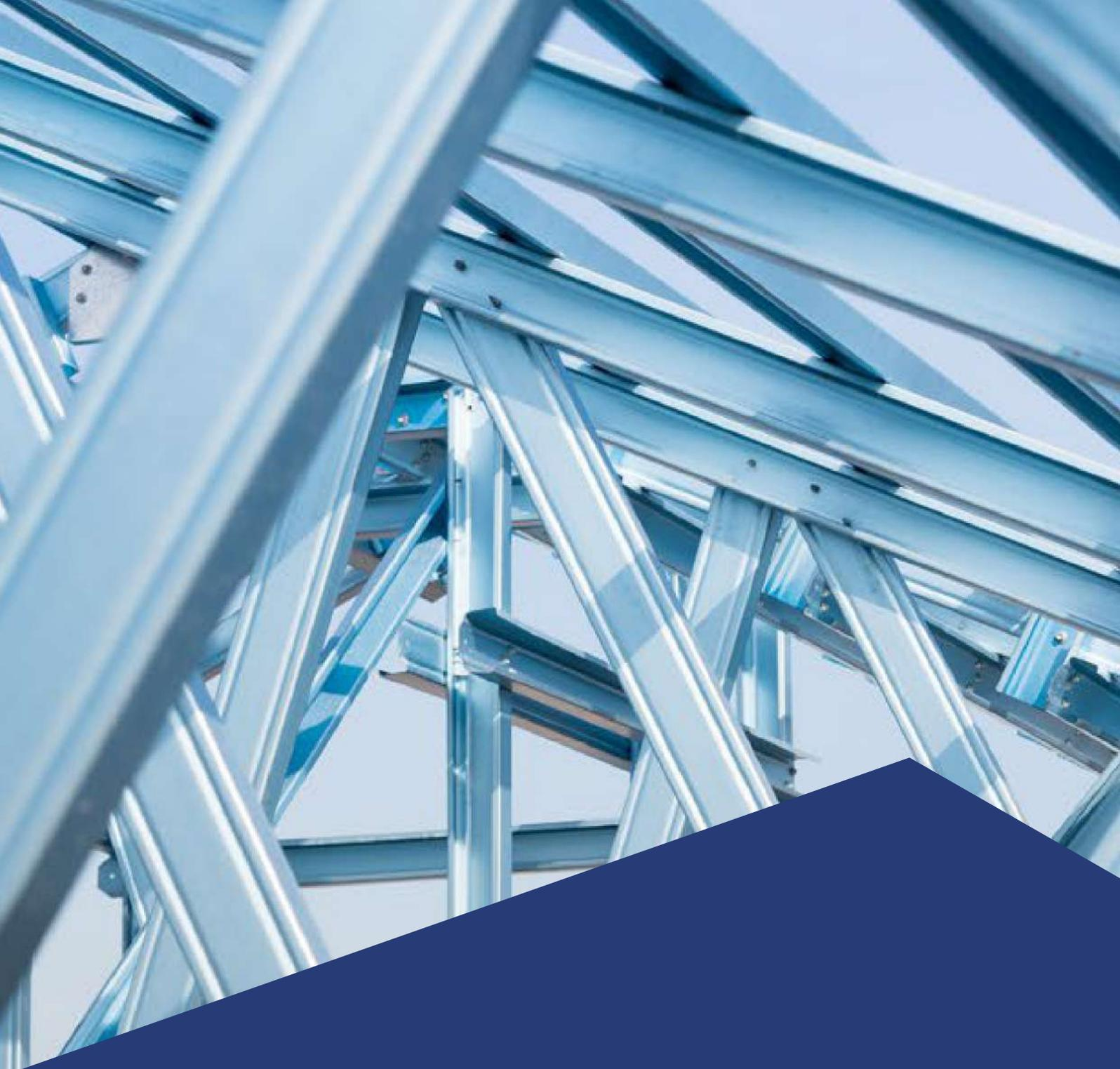
**“ A diferencia del acero al carbono, el acero galvanizado por su propia aleación contiene zinc en superficie, que actúa como protección catódica permitiendo utilizar sistemas anticorrosivos de menor espesor ”**
