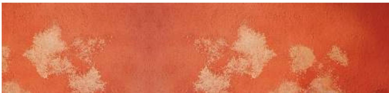
**Le farinage** est produit par l'action continue du soleil sur les façades et peut entraîner la dégradation du liant, laissant la peinture poudreuse en surface.
