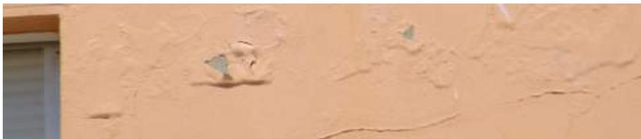
**Carbonatation** Il s'agit d'un processus lent et invisible qui consiste en la réaction de la chaux éteinte du ciment avec le dioxyde de carbone (CO<sub>2</sub>) de l'air, formant du carbonate de calcium. Il en résulte une baisse du pH qui rend l'armature en acier non protégée contre la corrosion. Ce processus aboutit à la corrosion de l'acier du béton, ce qui endommage gravement la structure.
